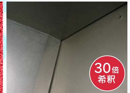
内壁面・パーテーション
